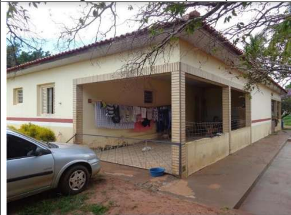
Figura 9. Casa de funcionários. (13.043)
